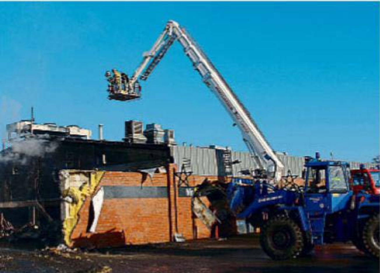
Das Technische Hilfswerk unterstützte die Aufräumarbeiten. Ein Teil des Gebäudes musste abgerissen werden.
