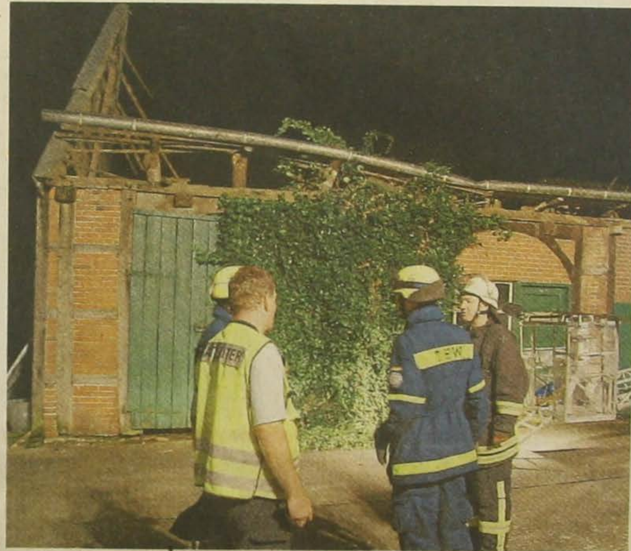
Gemeinsam sicherten Feuerwehr und Technisches Hilfswerk die eingestürzte Scheune. Foto: Große Hüttmann
