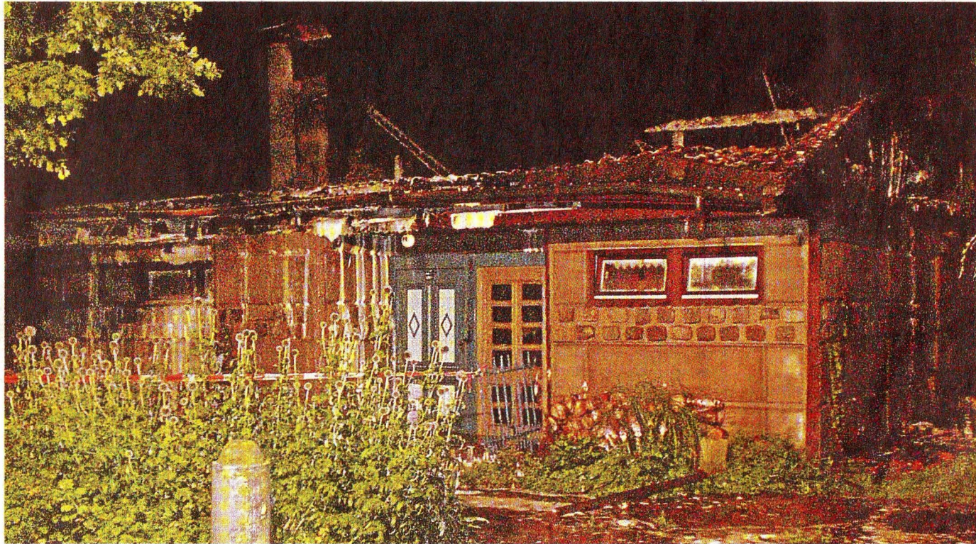
Von dem als Atelier genutzten Nebengebäude eines Anwesens in Lauheide blieben nach dem verheerenden Brand nur noch die Grundmauern stehen.
